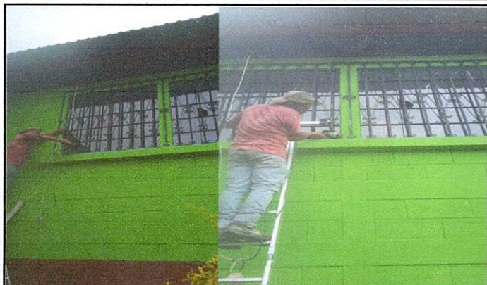
Foto 1: MEJORAMIENTO A SALÓN CON VENTANAS CORREDIZAS
