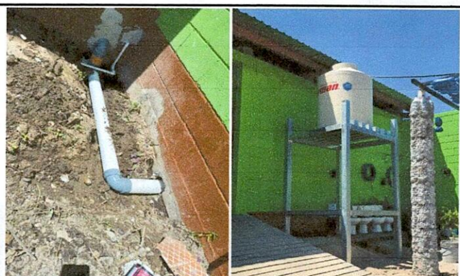
Foto 4: MEJORAMIENTO A INSTALACIÓN DE DEPÓSITOS DE AGUA
