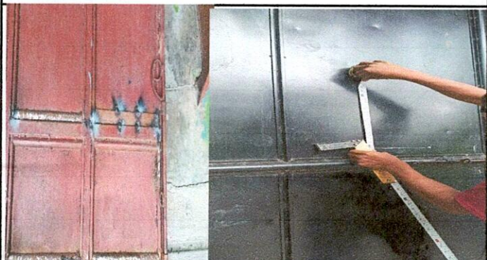
Foto 5: MEJORAMIENTO A PORTONES Y ENTRADA DE ABAJO
