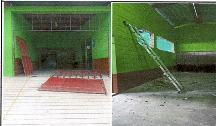
Foto 3: SUSTITUCIÓN DE PORTÓN PRINCIPAL E ILUMINACIÓN DE PASILLO
